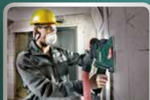
Без стола для индивидуальной ручной резки, например, при ремонте трещин и швов.
